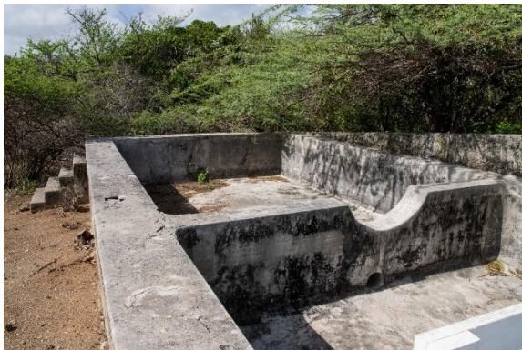
Figure 3. Waterbakken en een sakado in dam Patia, onderdelen van de waterwerken van Savonet.
